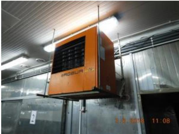
Фото 43 Газовый конвектор ROBUR M-30
