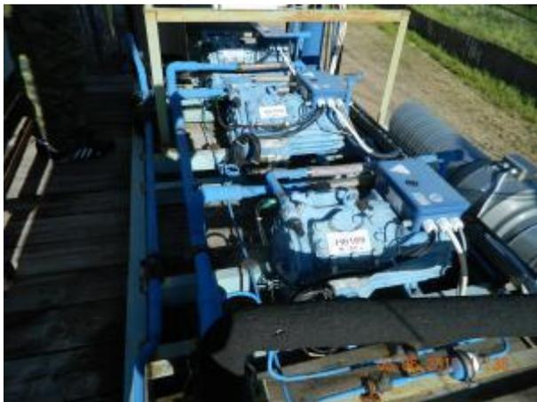
Фото 53 Холодильная установка с агрегатом АпК-МП-4-8-7461-60-Н-45-Эко
