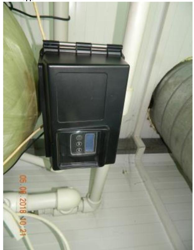
Фото 30. Фильтрационная установка для подготовки пит воды
