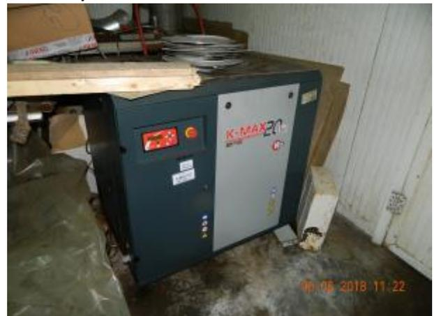
Фото 54 Компрессор винтовой FINI K-MAX
