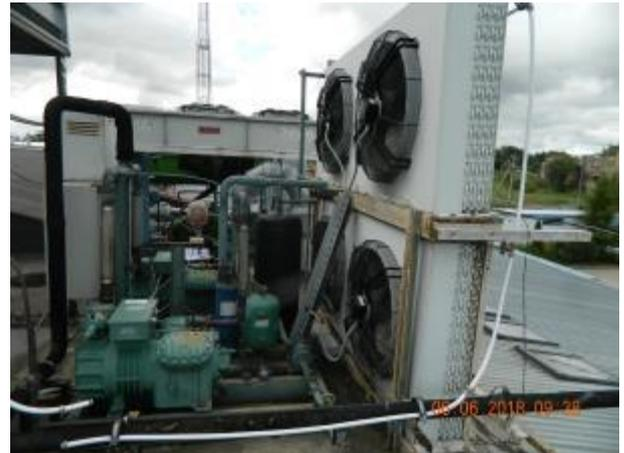
Фото 26. Холодильная установка с агрегатом АпК-МП-4-8-7461-60-Н-45-Эко
