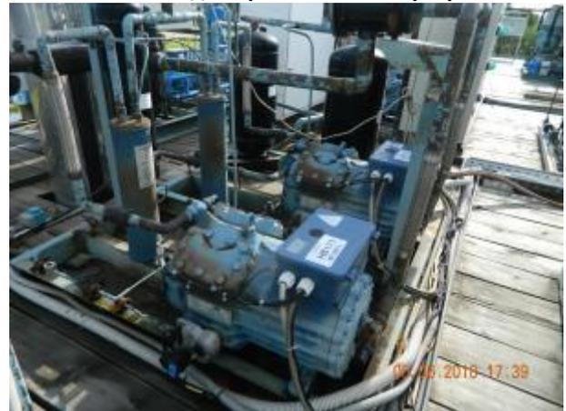
Фото 52 Холодильная установка с агрегатом АпК-МП-3-С-НХ4/555 Тольятти
