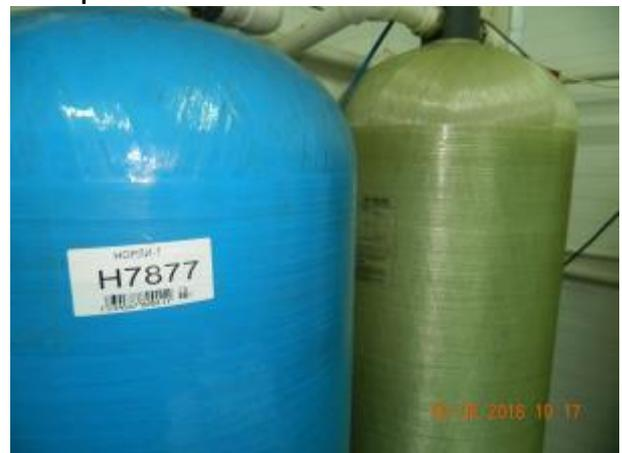
Фото 64 Фильтрационная установка для подготовки пит воды
