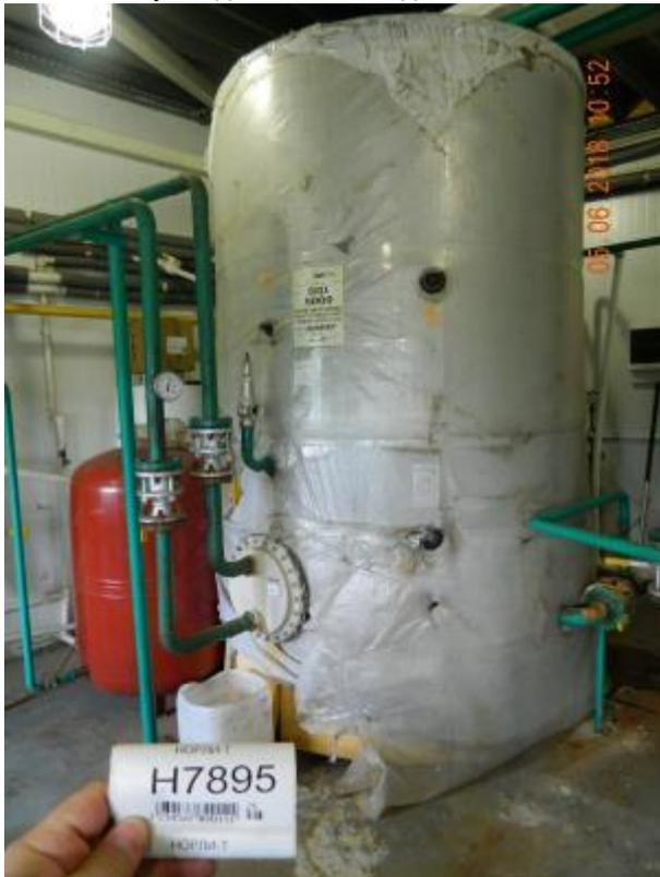
Фото 57 Бойлер BV SX 5000 с баком- аккумулятором
