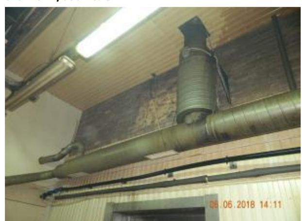
**Фото 6. Вентиляционное оборуд. (вент,-2, воздухонагрев.-1)**
