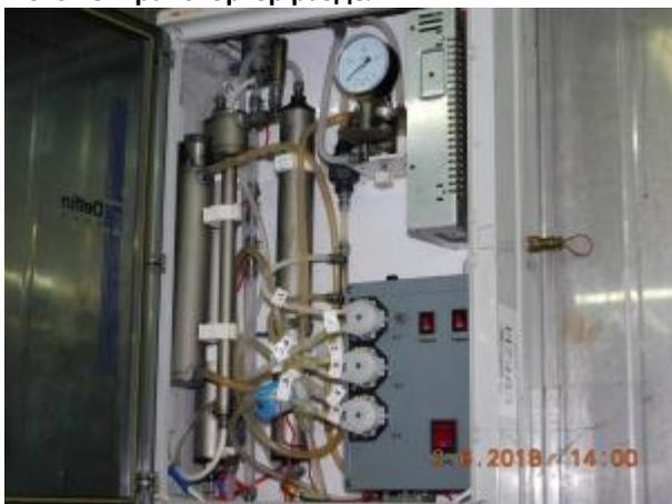
Фото 47 Установка СТЭЛ-АНК-СУПЕР-100 (для получения диз.растворов)
