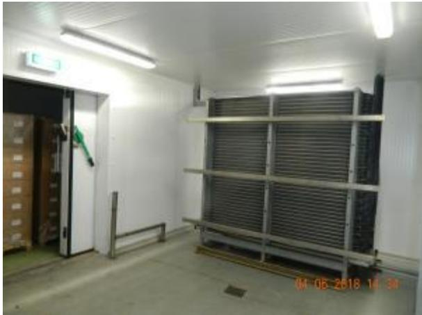
Фото 19 Вентилятор S4E630-AJ0101 (установлен в испаритель)
