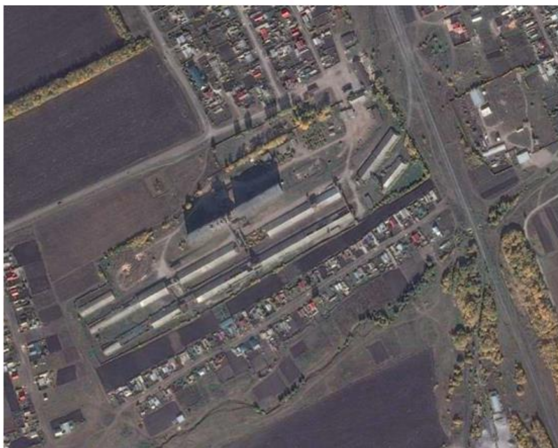
Рис.2 Территория Цильнинского элеватора
