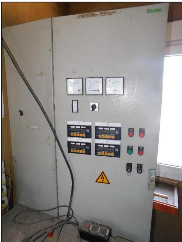
**Фото 154.** Кабина оператора и панель управления, LIEBHERR-MISCHTECHNIK GMSH, тип MOBILMIX
