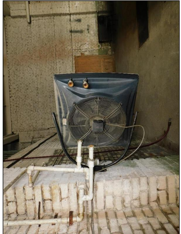
**Фото 119.** Тепловентилятор, мод. VTS EUROHEAT VOLCANO
