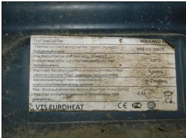
**Фото 120.** Тепловентилятор, мод. VTS EUROHEAT VOLCANO
