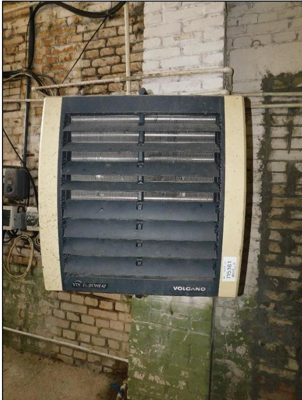
**Фото 118.** Тепловентилятор, мод. VTS EUROHEAT VOLCANO
